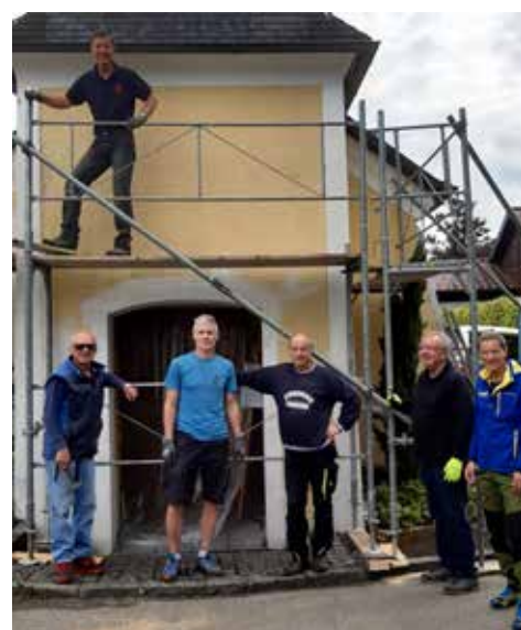
Beim Gerüstaufbau. Oben Klaus Brandner, unten Hias Gebetsroider, Roland Seiringer, Johann Reiter, Gerhard Marx, Peter Brandner.
